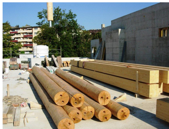
Livraison des piliers bois
