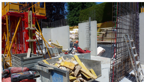
Bétonnage des murs en béton apparent
