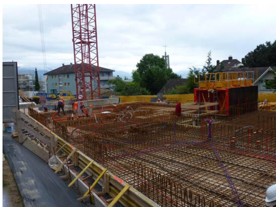
Bétonnage d'une dalle
