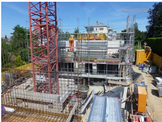
Installation de chantier : grue entre les deux bâtiments en cours de construction
