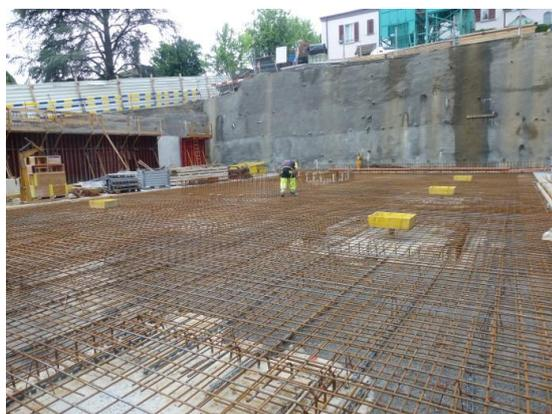
Fouille avec paroi clouée sur 8 [m] de hauteur
