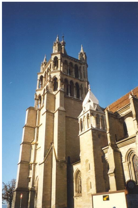
Tourelle Sud après travaux et Beffroi
