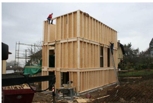
Montage de la charpente
