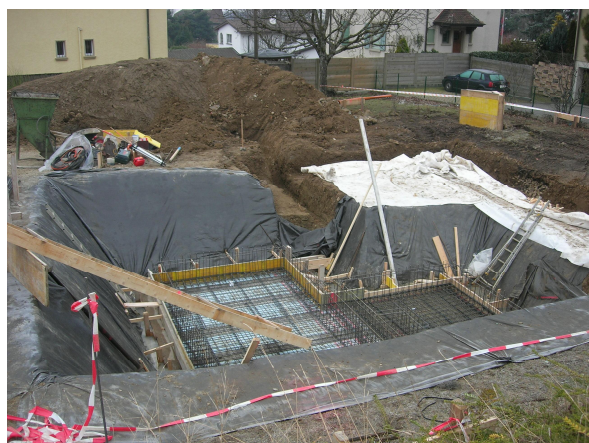
Terrassement + armature du radier
