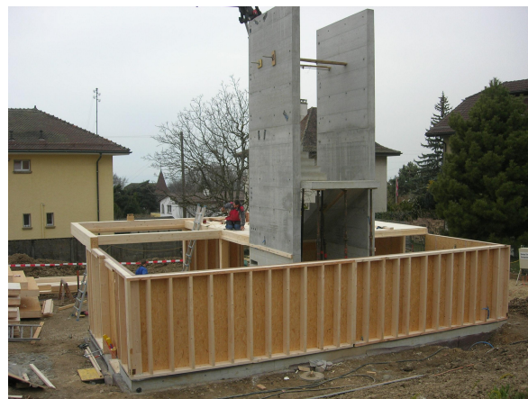
Noyau central en béton + Montage des parois bois
