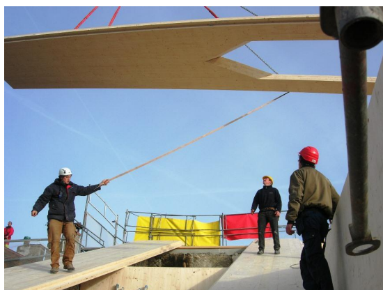
Montage de la nouvelle charpente
