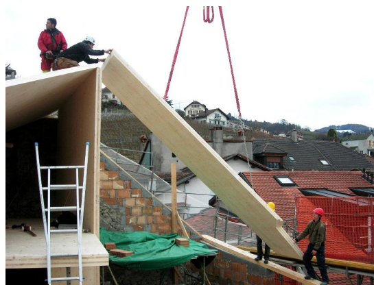
Montage de la nouvelle charpente
