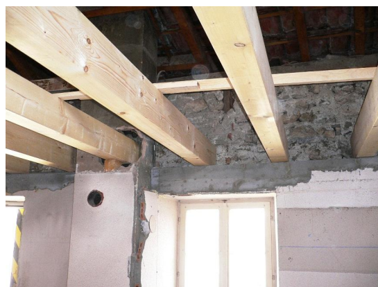
Nouveau plancher bois
