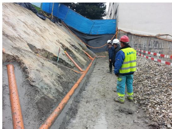
Mise en œuvre d'un système de drainage du talus nord de la parcelle.
