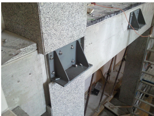
Console en acier pour appuis nouvelle dalle mixte.
