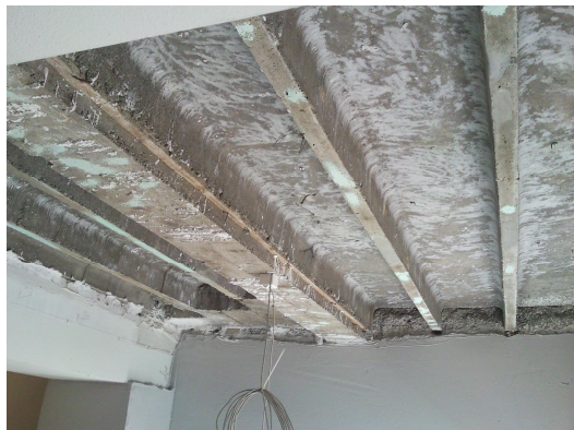
Réfection des dalles nervurées existantes.
