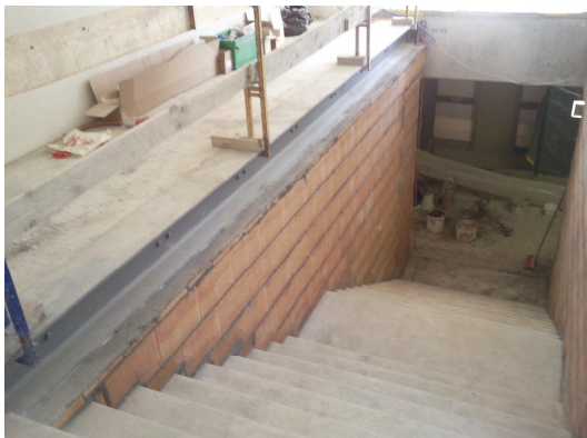
Une des nouvelles cages d'escaliers.
