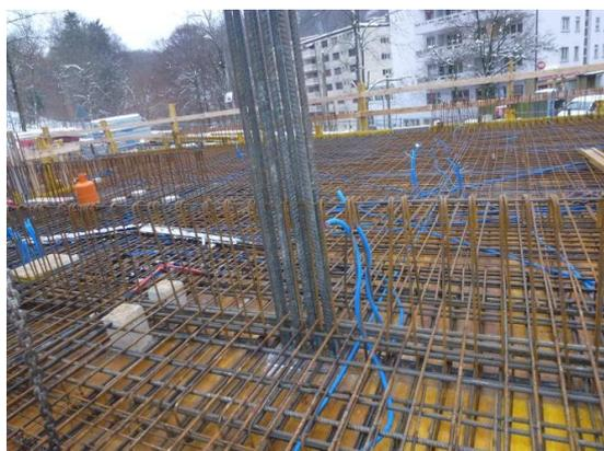
Armature de pilier isolé reprenant des voiles porteurs
