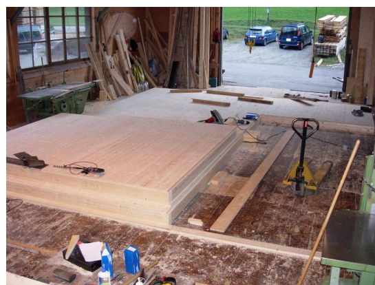
Réalisation des caissons bois en atelier
