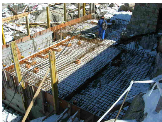
Partie de la structure sous-sol en béton armé
