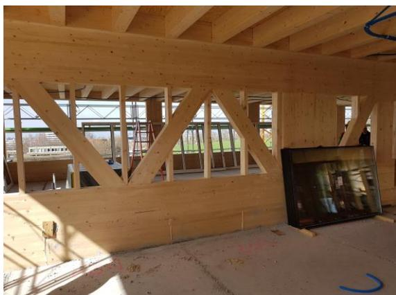
Poutre à treillis intégrée pour reprendre le porte-à-faux.
