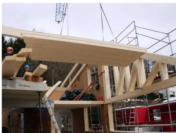
Pose d'un caisson bois
