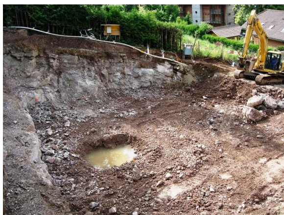
Terrassement en pleine masse à l'explosif
