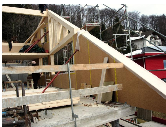
Montage de la charpente
