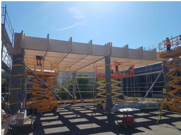
Assemblage sur chantier des parties de grilles de poutres pour former un ½ champ complet préfabriqué monté par grue.
