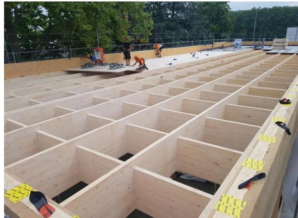
Stabilisation de la grille de poutre de toiture par des panneaux 3-plis vissés sur la partie supérieure de la grille de poutres
