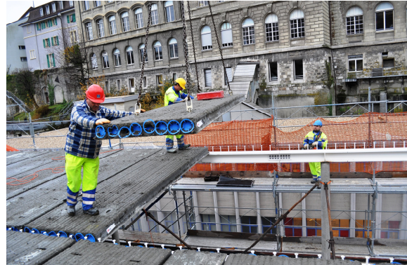
Éléments de dalle préfabriqués en béton précontraint.
