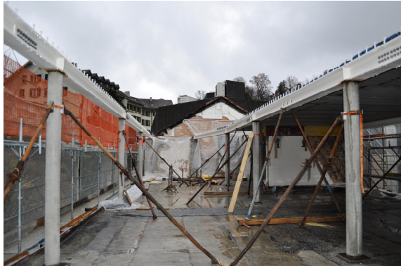
Charpente métallique avec peinture intumescente.
