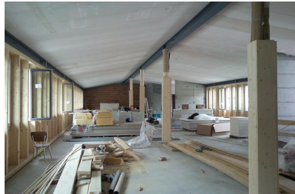
Construction mixte du dernier étage en bois, acier et dalle Ytong.
