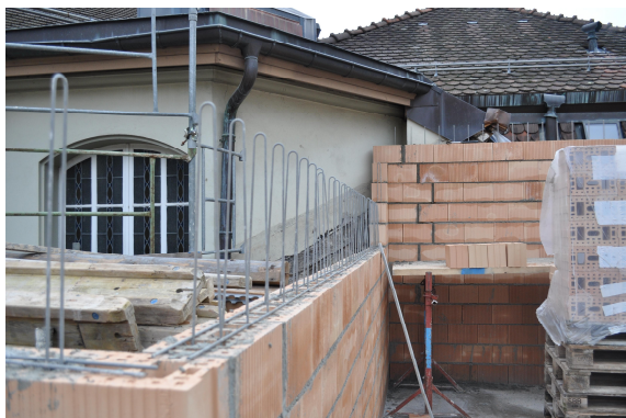
Mise en œuvre de murs en maçonnerie armée.
