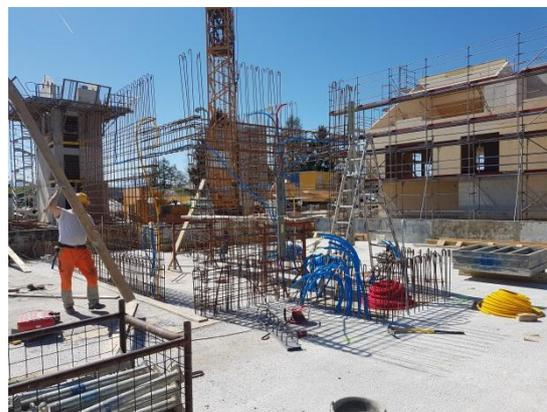
Infrastructure et cage d'escalier en BA recyclé, coffrage montant des cages, superstructure en bois
