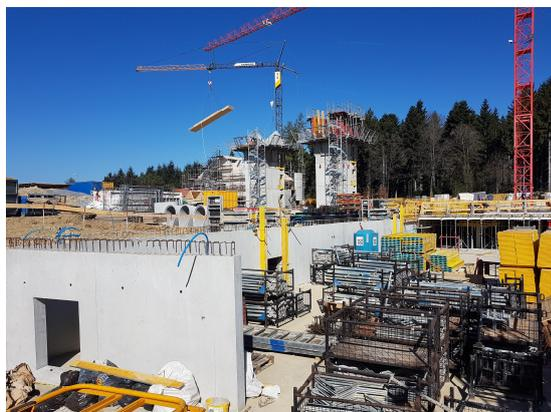
Réalisation du parking et sous-sol partiels des bâtiments. Misapor sous les fondations.
