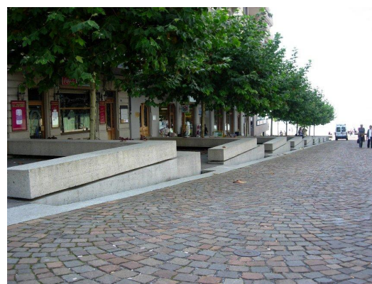
Neuf terrasses monolithiques de 5m x 5m. Tous les joints de maçonnerie ont été traités en négatif
