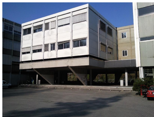
Bâtiment du centre sportif. Type de structure défavorable vis-à-vis du parasismique
