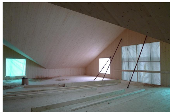
Dalle, parois et toiture en bois
