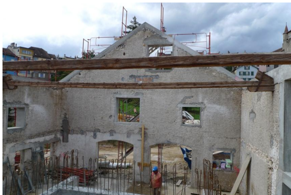
Stabilisation des murs existants, bétonnage d'arases, création des nouvelles fenêtres
