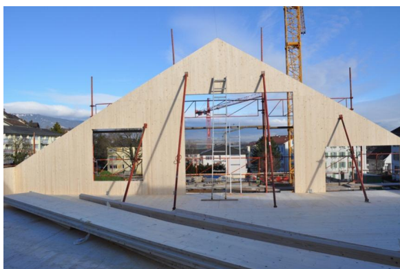
Panneau contrecollé supportant la toiture
