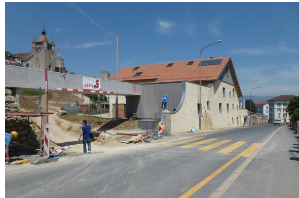
Création d'une passerelle de 19 m de long
