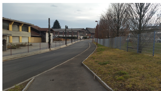
Nouvelles bordures et aménagement végétalisé
