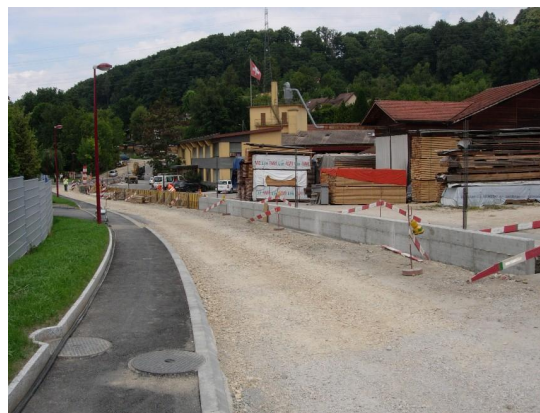
Compactage du criblé, mise à niveau
