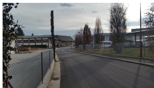
Nouvel enrobé bitumineux
