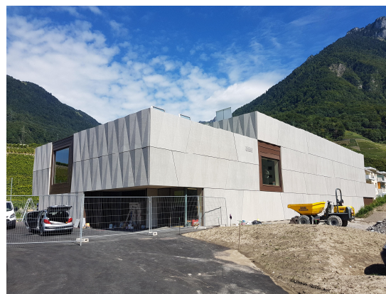
Façade en éléments béton préfabriqués avec facettes plissées
