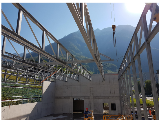
Montage de la charpente
