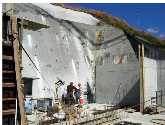
Bétonnage du sous-sol
