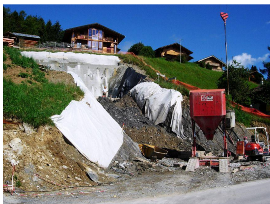
Terrassement / Travaux spéciaux
