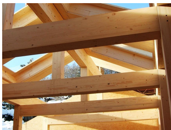
Montage de la charpente
