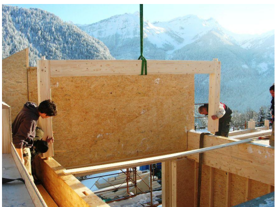
Montage de la charpente
