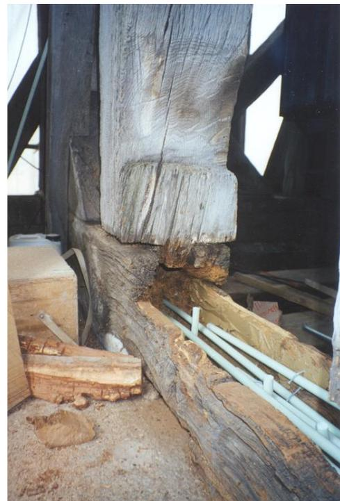
Renforcement par barres de fibres de verres noyées ultérieurement dans une résine époxy. La poutre renforcée est fermée par des panneaux de chêne.
