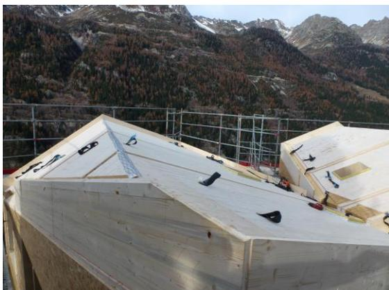
Géométrie irrégulière de la toiture faite de caissons bois préfabriqués, sans pannes. Montage hélicoptéré.
