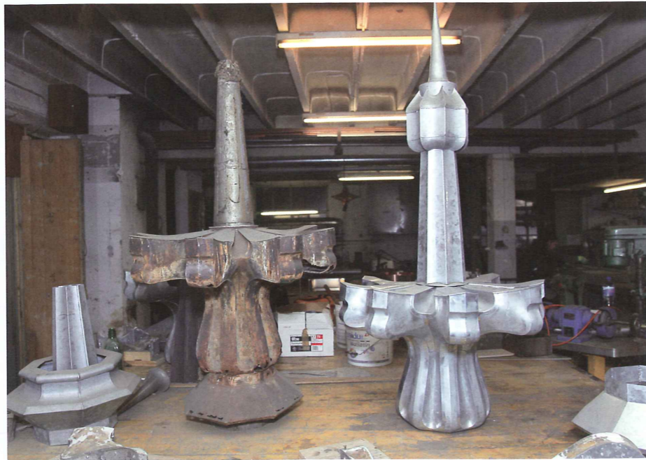
Des moules en résine ont été nécessaires pour reconstituer les pièces.
