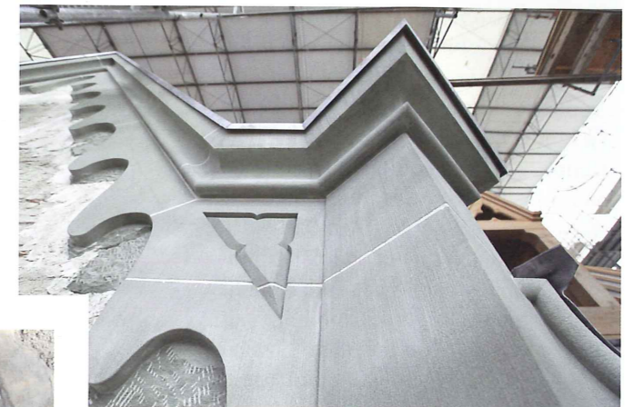
La consolidation des anciennes pierres s'est faite avec des produits durcisseurs.
