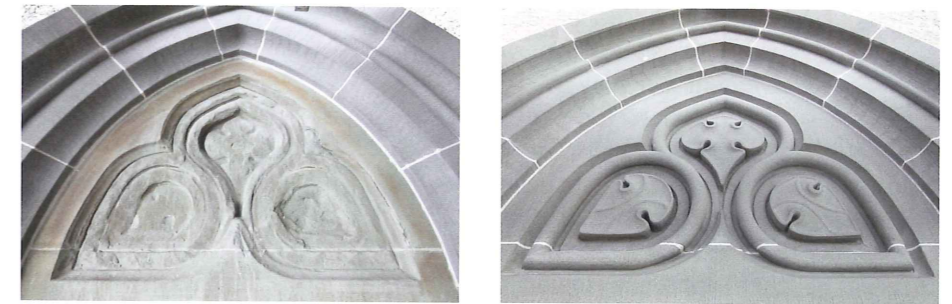
Les pierres ont été débitées en atelier et toutes les finitions ont été réalisées à la main, sur place.
