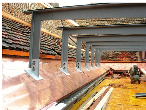
Cadres Héliportés et assemblés sur l'avant-toit des charpentes renforcées
