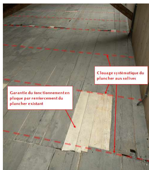
Fonctionnement du plancher en « diaphragme »
