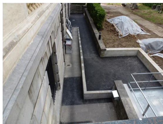
Nouvelle rampe d'accès nord et plateforme élévatrice
