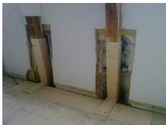
Consolidation de la structure bois existante
