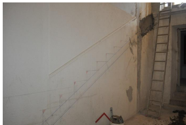
Traçage du nouvel escalier
