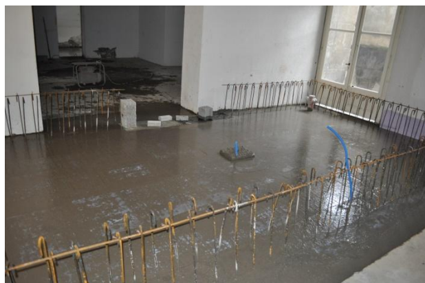
Création d'une nouvelle pièce dans les sous-sols
