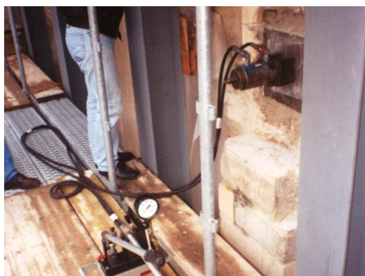
Mise en tension des nouveaux tirants de la Nef
