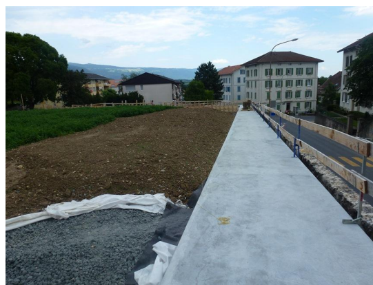
Bétonnage du nouveau chemin de ronde
