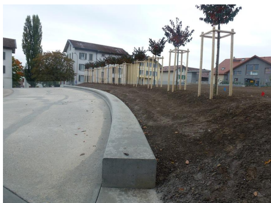
Bétonnage des bancs
