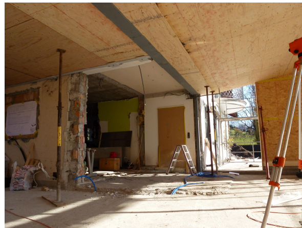
Reprise de la villa existante et de la nouvelle toiture
