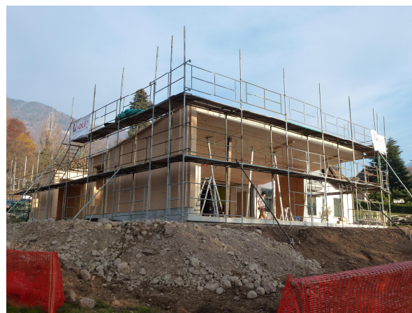
Nouvelle structure bois
