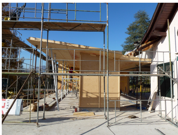
Agrandissement en caissons préfabriqués en bois
