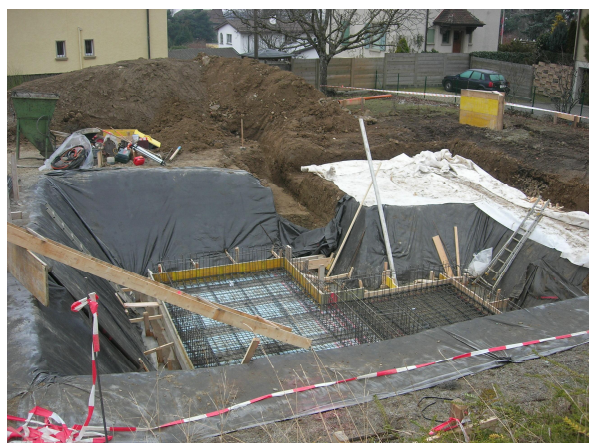
Terrassement + armature du radier
