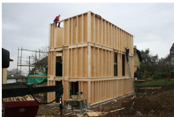
Montage de la charpente
