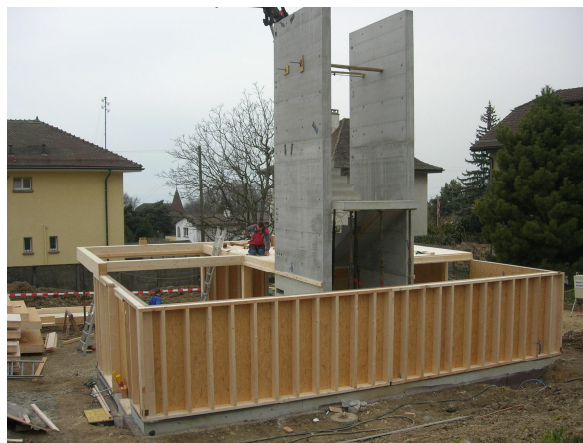
Noyau central en béton + Montage des parois bois
