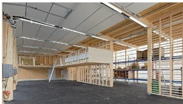
Vue intérieure de la partie halle.
