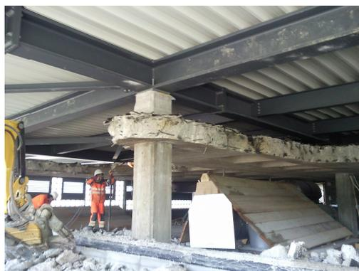
Démolition dalle existante après la pose de la charpente de la nouvelle toiture.
