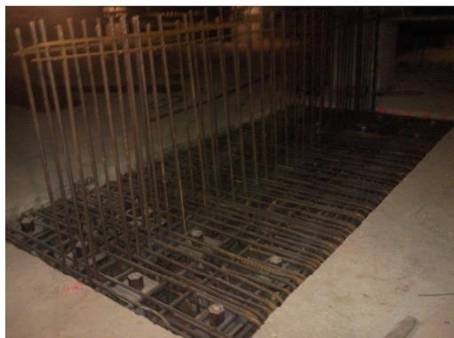
Fondations en béton armé avec micropieux pour confortement parasismique.
