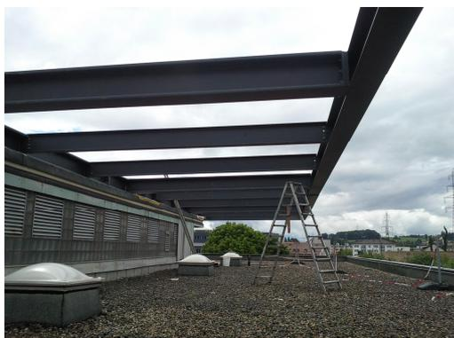
Charpente métallique de la nouvelle toiture avec porte-à-faux sur 4 côtés de 5,5[m] de portée.
