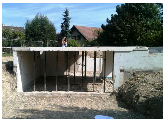
Vue de l'existant conservé
