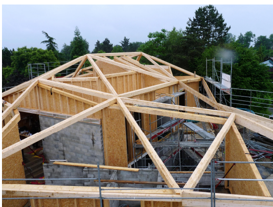
Solive de la toiture
