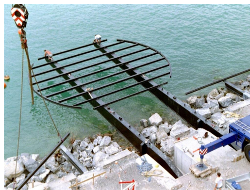
Pose des profilés cintrés et des pannes transversales
