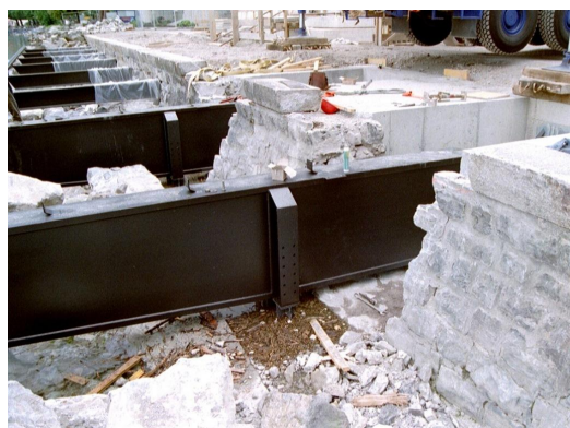
Ancrages des profilés dans le béton
