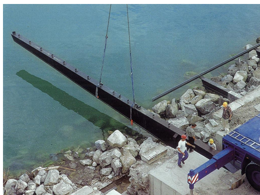
Mise en place des profilés principaux
