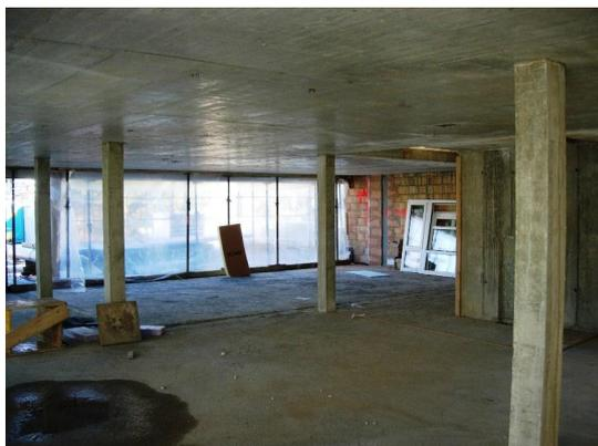
Structure : Piliers et dalles en béton armé
