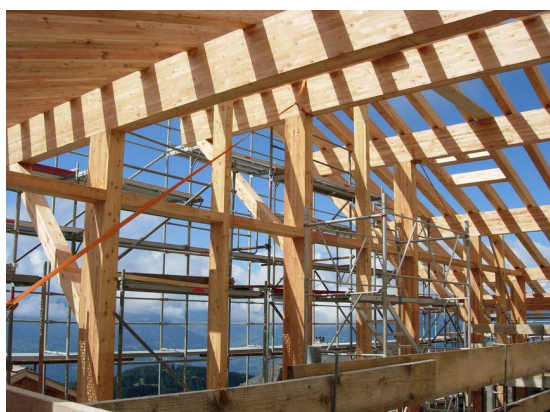
Façade avant avec charpente
