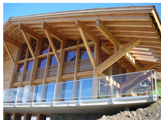
Reprise de l'avant toit triangulé
