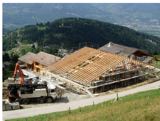
Pose de la charpente
