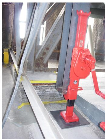
Remplacement des appuis rouillés du beffroi
