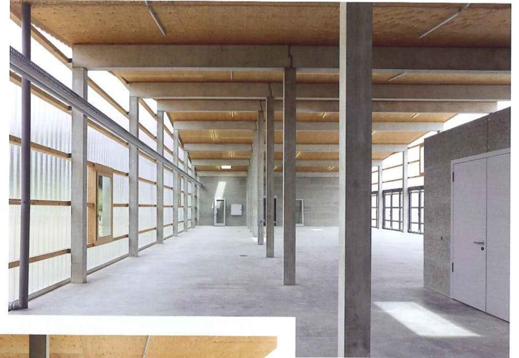
La surchauffe du bâtiment est évitée par l'utilisation du polycarbonate en «double peau», la lame d'air interstitielle le ventilant naturellement.
