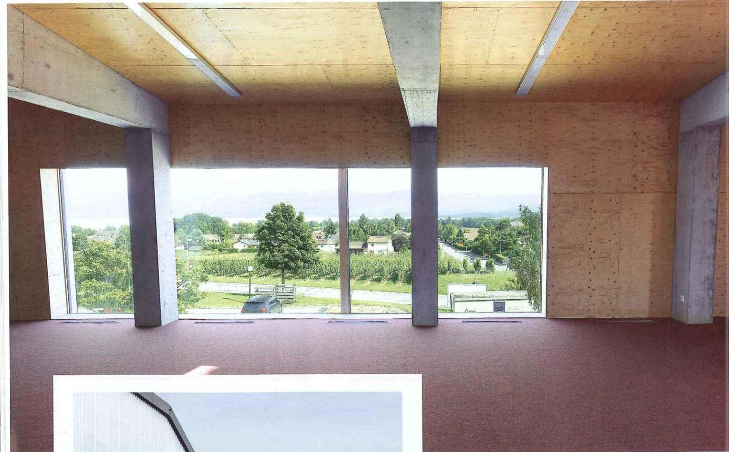
Dans cette halle, la façade est complètement isolée et flanquée d'un mur en plots, permettant d'offrir des locaux chauffés.
