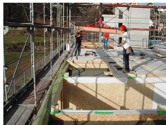
Construction préfabriquée en bois
