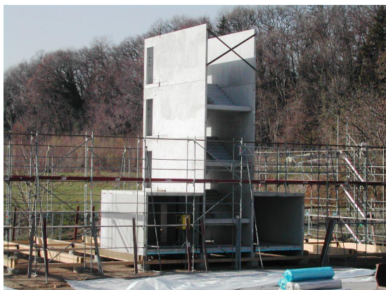
Cage d'escalier et cellule sanitaire préfabriquée, Noyau de stabilisation.
