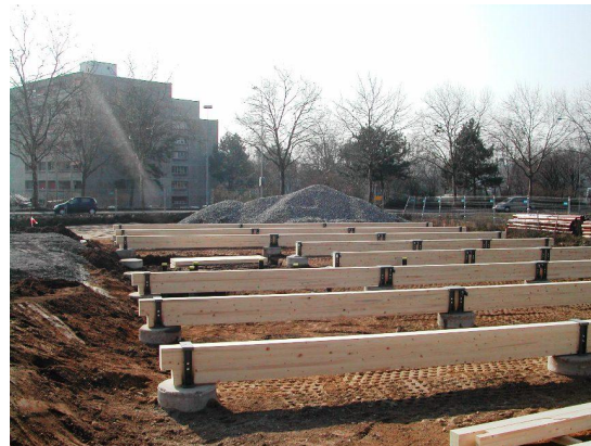
Zoom sur les fondations
