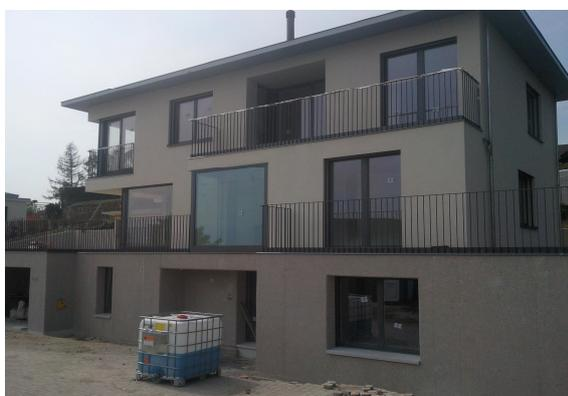
Béton apparent et bouchardé à l'étage du rez en façade sud.
