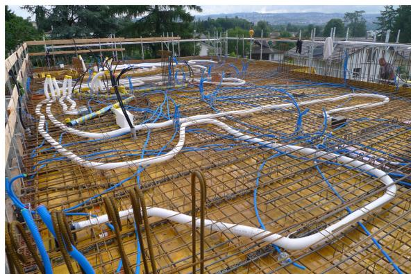
Ferrailage et pose des techniques en dalle sur rez.
