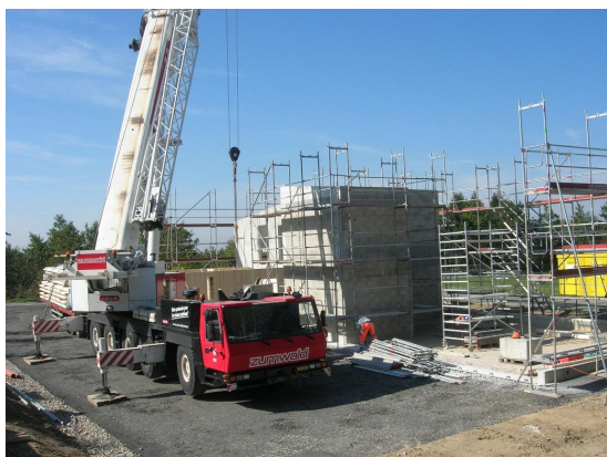
Radier et dalle béton / Murs en briques
