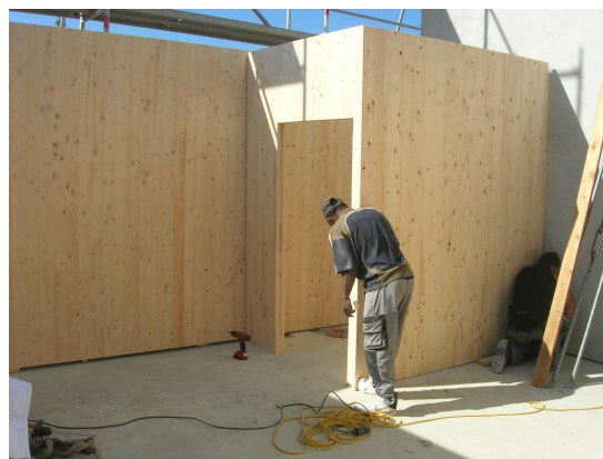
Montage des cloisons en bois
