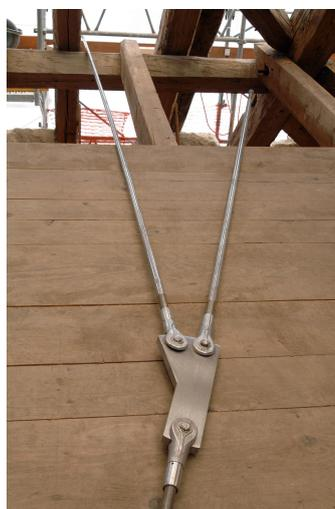
Renforcement de la charpente bois par la mise en place de nouveau tirant inox s'adaptant aux géométries irrégulières.
