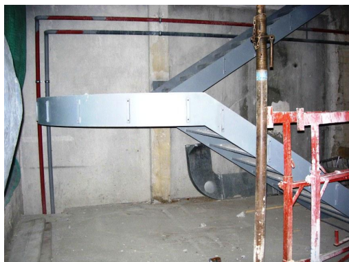
Pose de la structure
