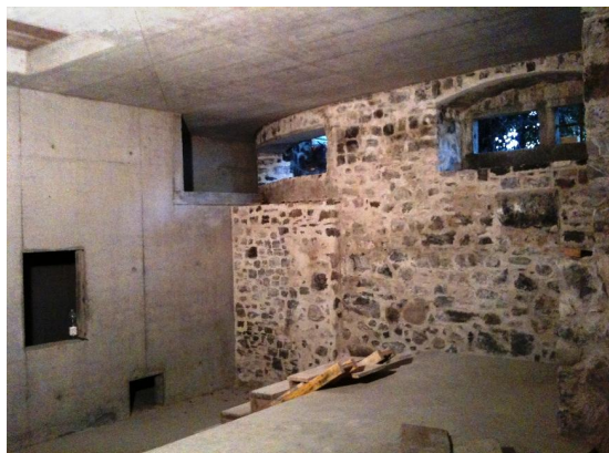
Création d'un local Pellets dans les sous-sols du Château
