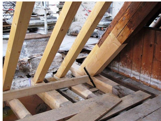
Assainissement de la charpente existante
