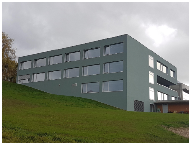
Façade nord-est du bâtiment.
