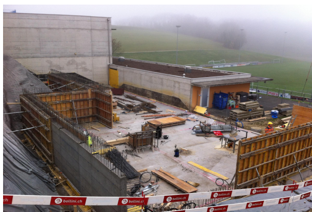
Construction des murs sur radier.
