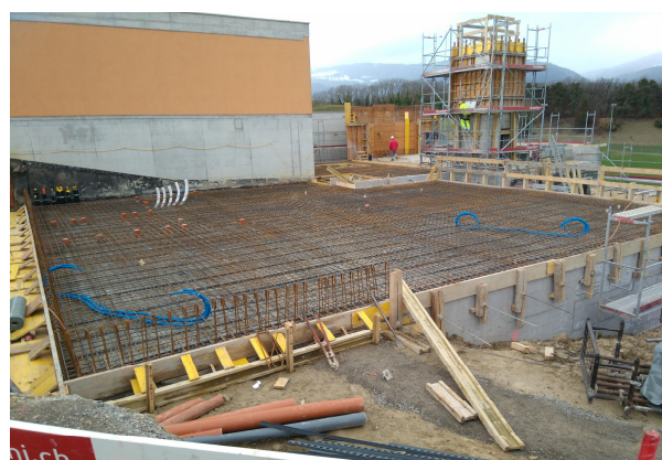
Armature dalle niveau +1.
