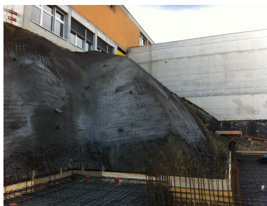
Fouille avec paroi clouée de 6 [m] de hauteur.
