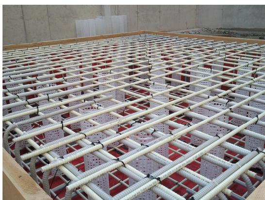
Pose des armature spéciales en fibres de verre avec ligatures et paniers en plastique
