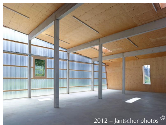
Sommiers + piliers préfabriqués
