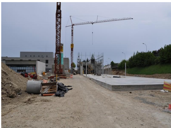
Création du radier de la halle
