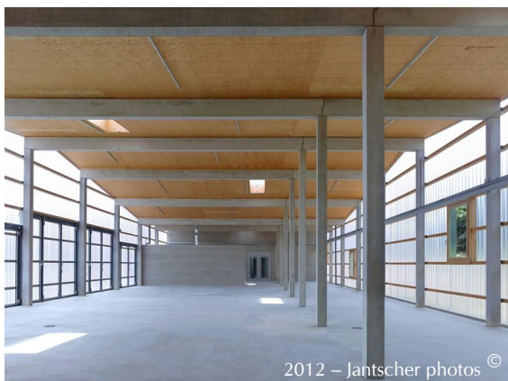
Sommiers + piliers préfabriqués
