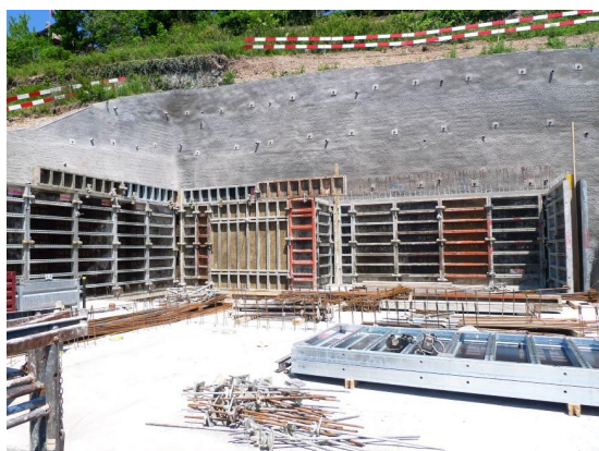
Bétonnage du sous-sol
