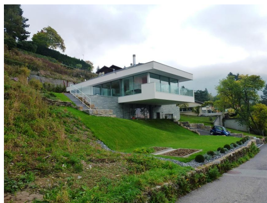
Villa terminée, porte-à-faux de 6 mètres
