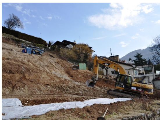
Terrassement, aménagement d'une piste de chantier
