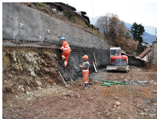
Création des parois clouées
