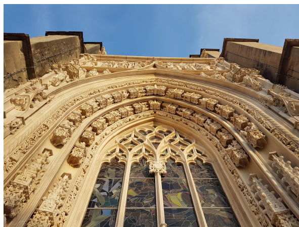
Vue en contre-plongée de la partie supérieure du portail nettoyé
